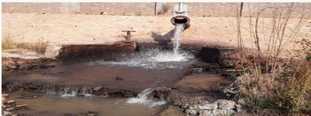
Fig. n° 4. Tuyau de déversement d'acide et des eaux usées de COMMUS dans la rivière Kaitende
