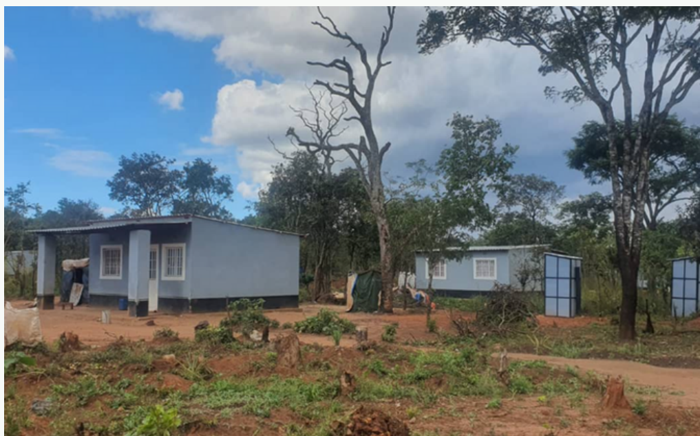
Fig. n° 6. Les maisons construites par Kamo Copper sur le site de réinstallation à Kaponda
